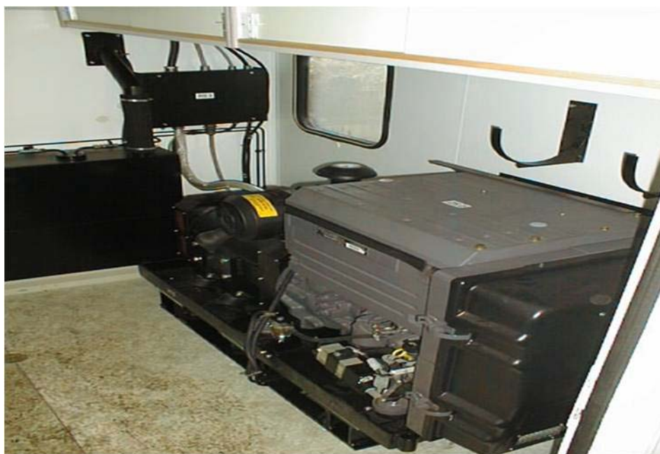
Obrázek 5.23 Vnitřní vybavení rozvodny spojovacích uzlů SU 230p
